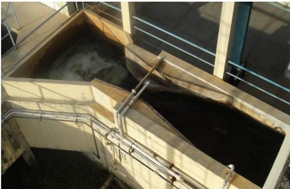
Figura 4.3 – Calha Parshall da ETA Extremoz.
