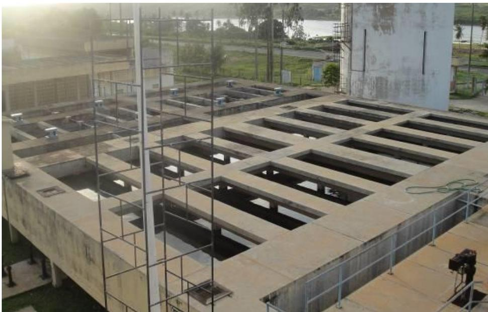
Figura 4.1 – Vista geral das unidades de floculação associadas aos decantadores da ETA Extremoz.
