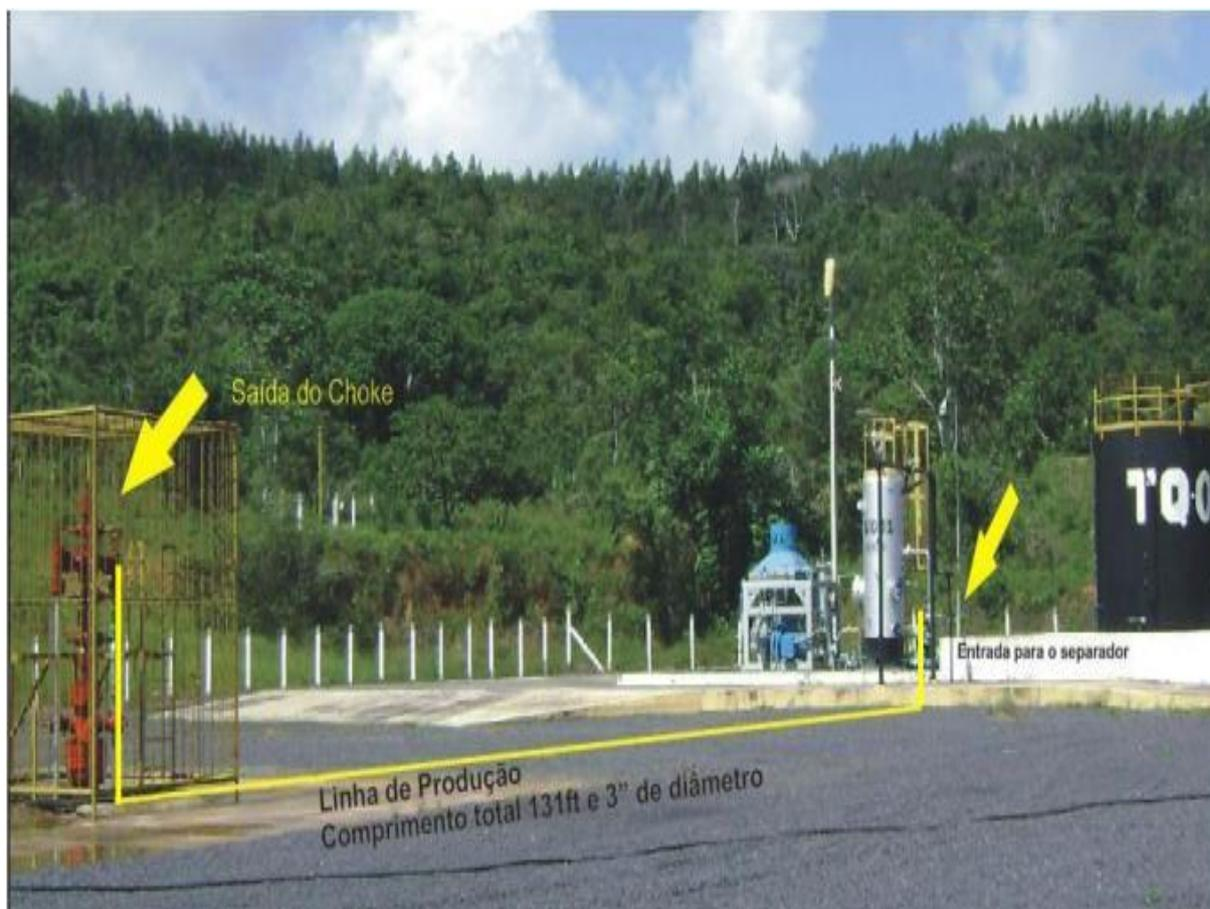
Figura 7- Sistema de produção do poço 1-FMO-001-BA
