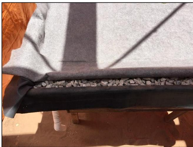
Figura 3.5: Detalhe da faixa de brita entre o geotêxtil e a geomembrana.
