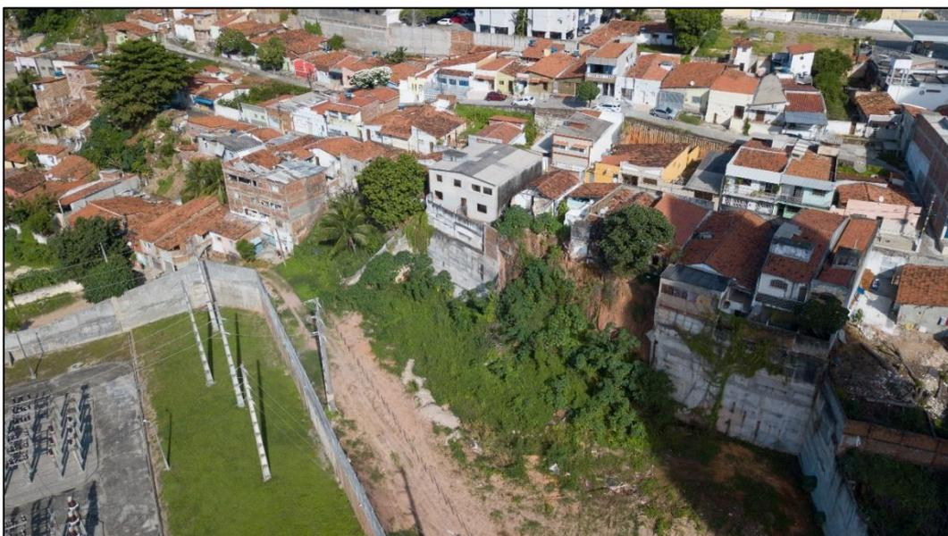
Segundo relato extraído do laudo técnico elaborado por Santos Júnior, Severo e Freitas Neto (2014), as intervenções sobre o talude natural, alteraram o fluxo de água subterrânea no local, passando a ser observado, antes da construção da contenção, afloramento de água durante períodos chuvosos no talude de corte.
