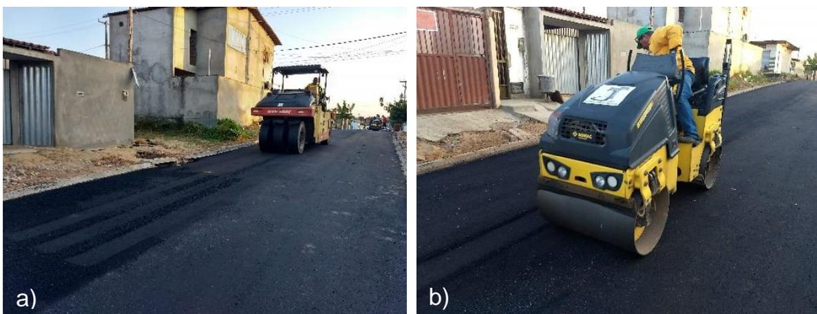
Por fim, o produto final gerado foi um pavimento asfáltico que contém agregados reciclados em sua composição e teor ótimo de ligante empregado da ordem de 5,4%, na qual foram analisados seus aspectos visuais e funcionais durante um período de quatro meses. A Figura 25 ilustra detalhes do trecho experimental executado.
