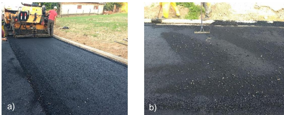
Após o nivelamento, os rolos pneumático e liso através do peso próprio e vibração, respectivamente, proporcionaram a compactação e acabamento final. Enquanto o pneumático selou a superfície, o liso contribuiu também para que o asfalto não tivesse marcas de compactação (Figura 24).
