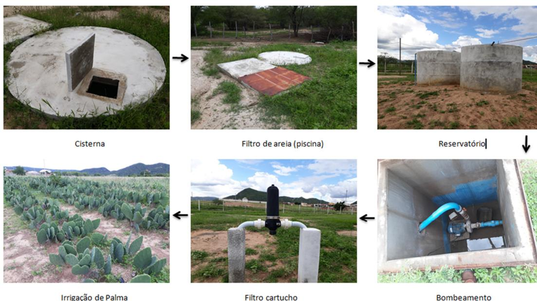
Figura 11 – Esquema do pós-tratamento utilizado no sistema de Santana do Seridó/RN.
