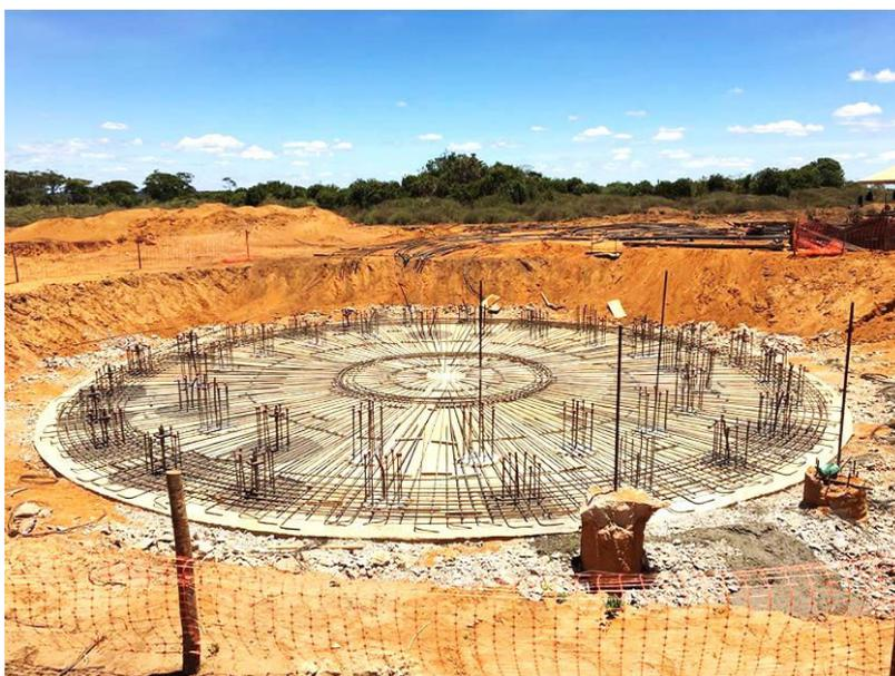
Figura 2.11 – Fundação do tipo bloco sobre estacas.
