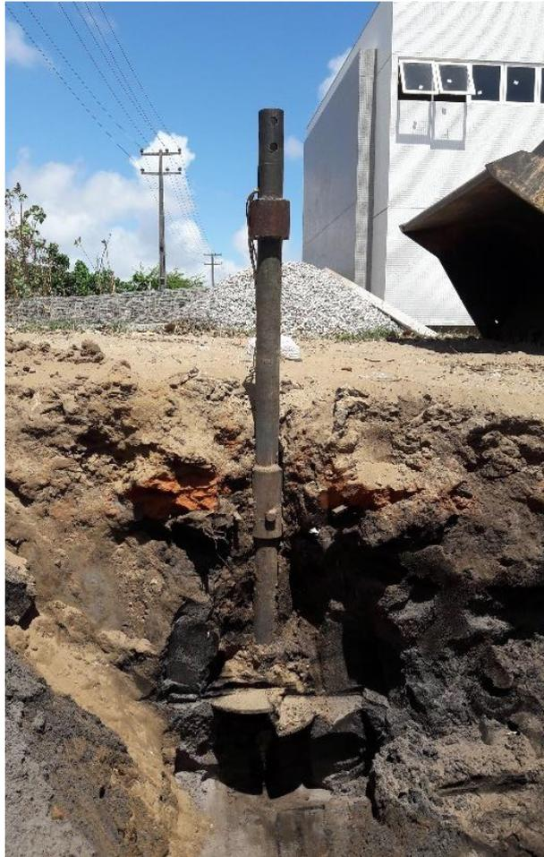
Figura 3.5 – Vista lateral de um corte após conclusão da última prova de carga.
