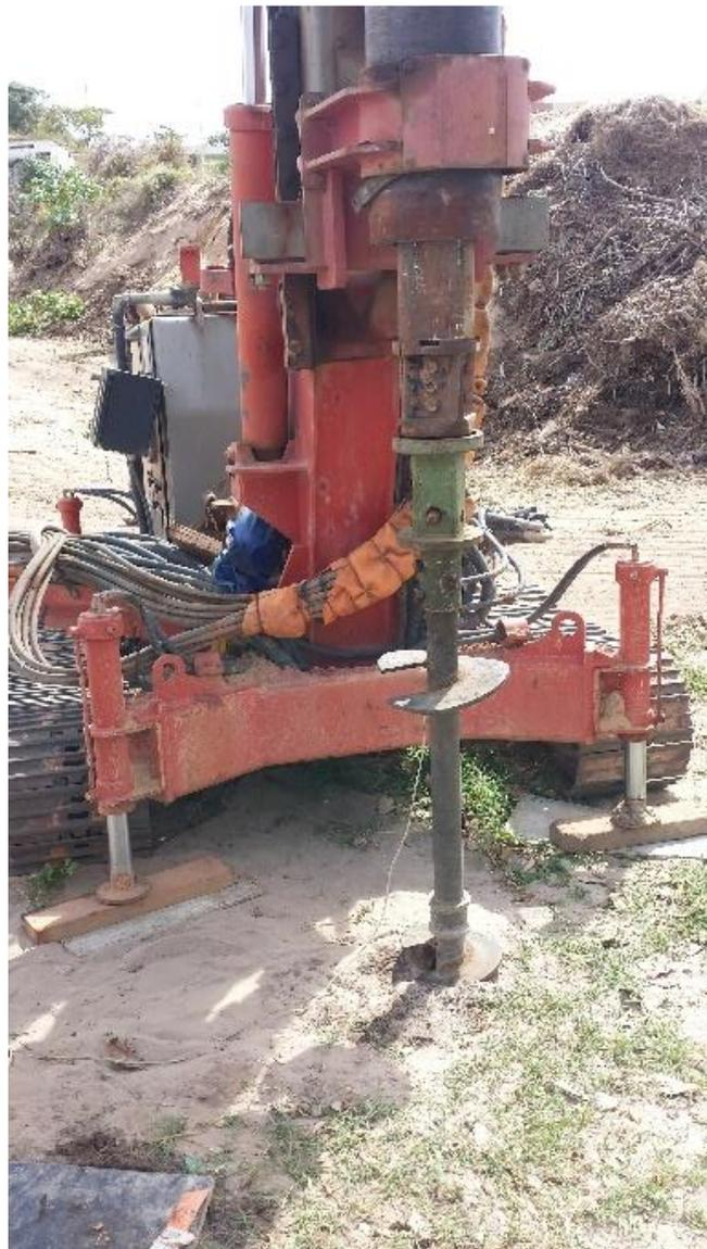
Figura 3.14 – Instalação da estaca.
