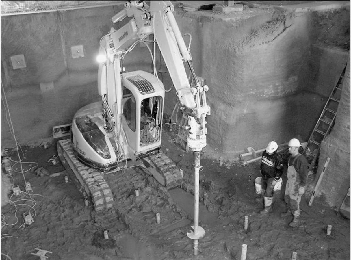
Figura 2.4 – Adaptação de um motor hidráulico em uma retroscavadeira (Perko, 2009).
