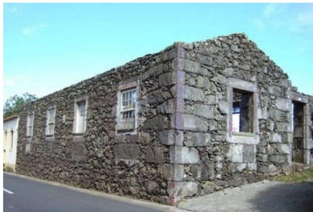
Figura 2.6: Edificação com alvenaria de pedra
