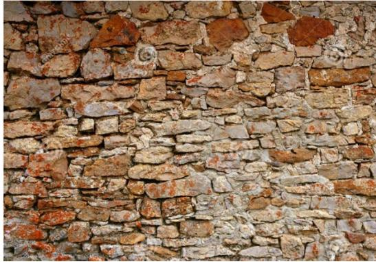
Figura 2.7: Alvenaria de pedra
