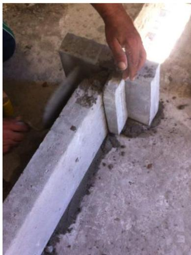
Figura 4.30 - Aplicação da 1ª fiada de alvenaria no entorno dos banheiros em pré-moldado na obra C.
