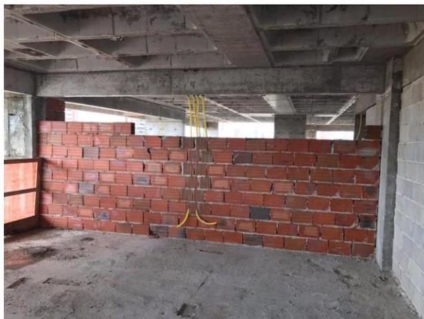
Figura 4.51 - Falta de terminalidade de alvenaria na obra C.
