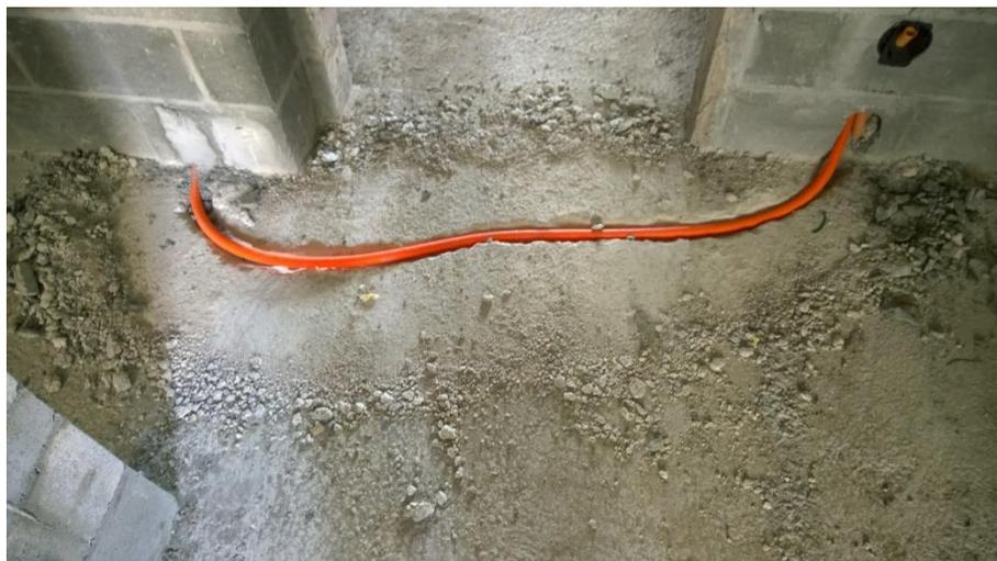
Figura 4.8 - Abertura da laje para passagem de tubulação elétrica na obra A.
