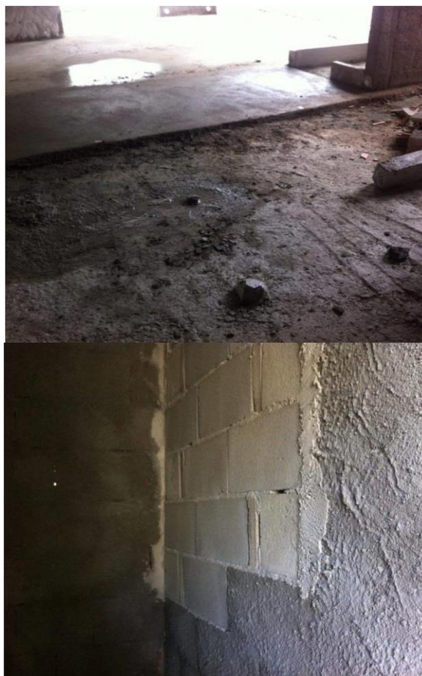
Figura 4.35 - Atividades do pacote de revestimento interno com falta de terminalidade na obra C.
