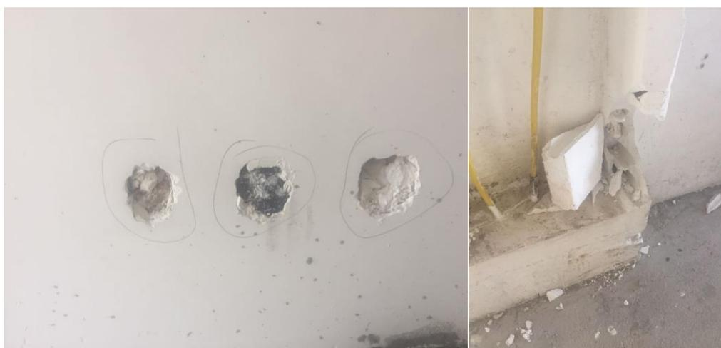
Figura 4.10 - Perdas por retrabalho identificadas com lápis na parede na obra A.
