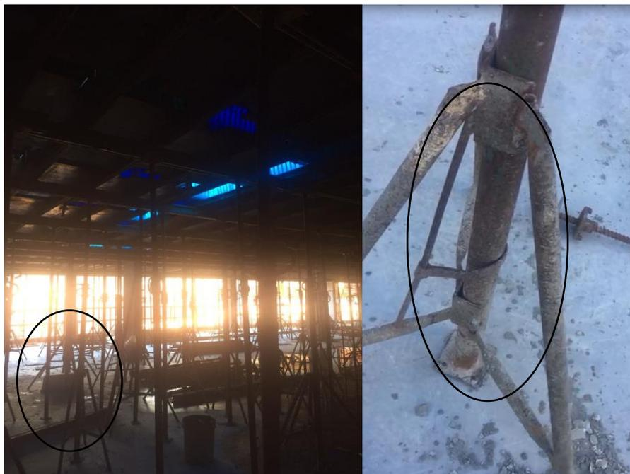
Figura 4.33 - Escoramento metálico improvisado, apoio móvel na obra C.
