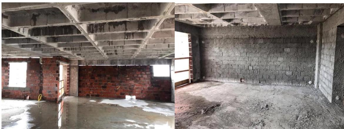
Figura 4.50 - Alteração da sequência dos pacotes contramarco e revestimento interno na obra C.
