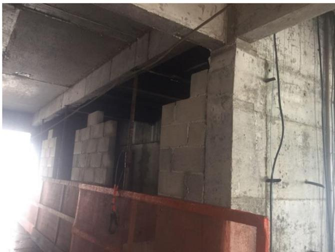
Figura 4. 43 – Alvenaria de vedação com falta de terminalidade na obra C.
