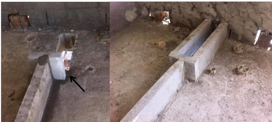
Figura 4.46 - Pré-moldado com dimensões diferentes do projeto na obra C.
