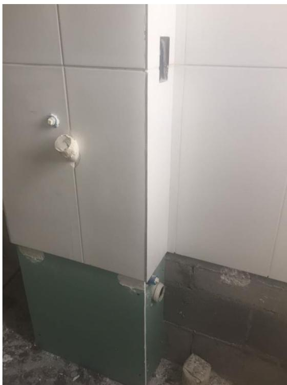
Figura 4.6 - Substituição de material de shaft na obra A.
