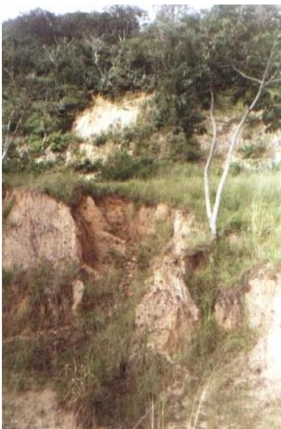
FIGURA 5.14 – Ravinas e voçorocas na encosta da BR-101.
