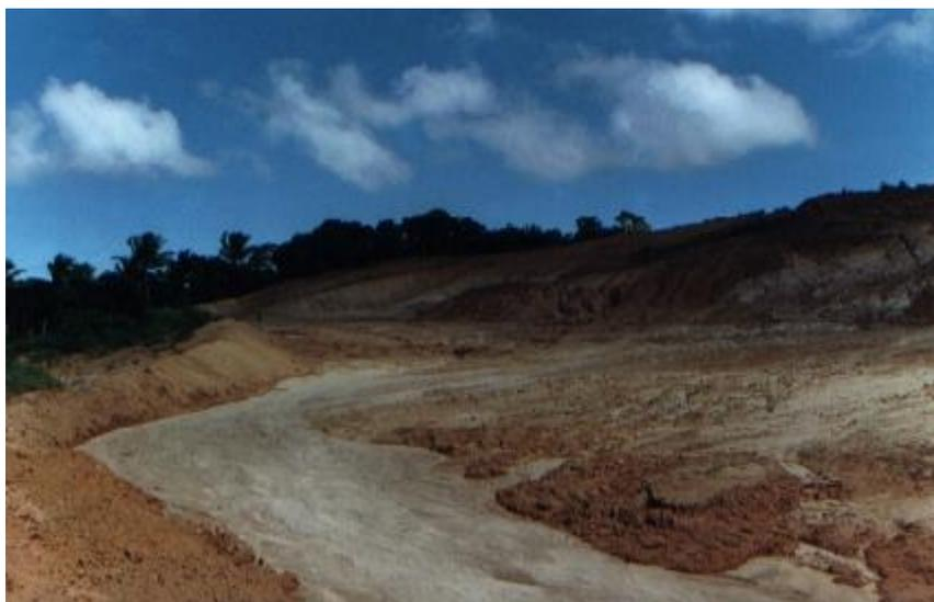
FIGURA 5.15 – Local de empréstimo de material com instabilizações.
