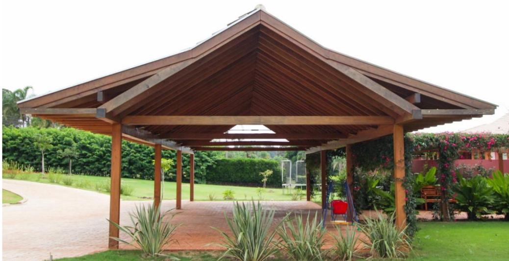
Figura 2.2 Elementos estruturais em madeira maciça serrada
