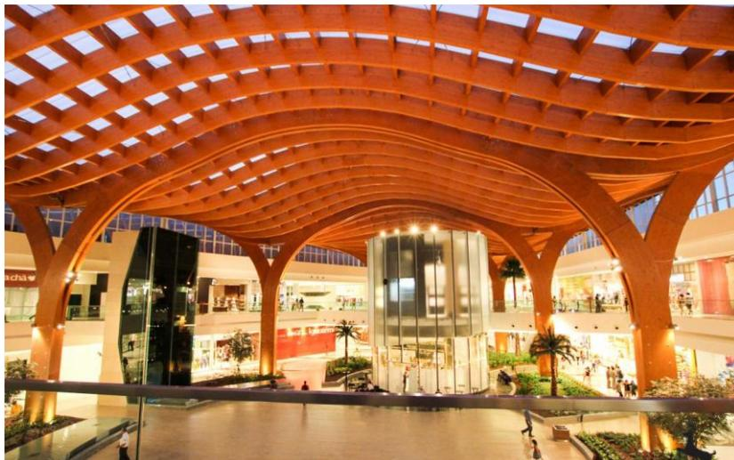
Figura 2.9 Elementos estruturais em MLC
