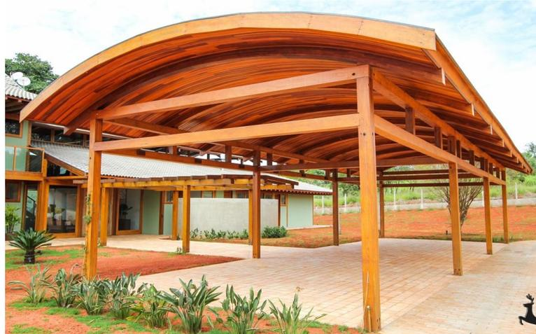
Figura 2.1 Sistema pilar e viga com elementos em MLC
