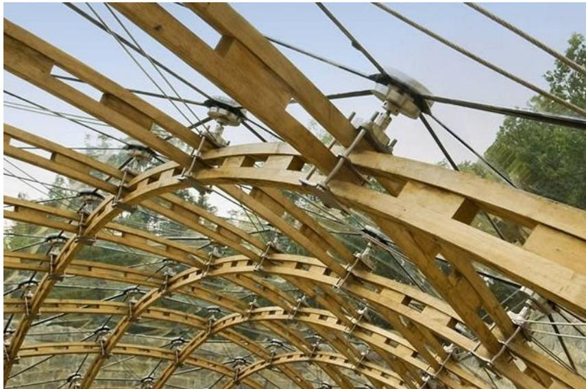
Figura 2.6 Detalhe das ligações do sistema Gridshell
