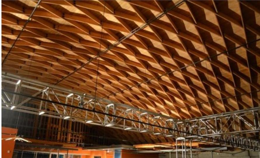
Figura 2.7 Sistema Estrutura Lamelar
