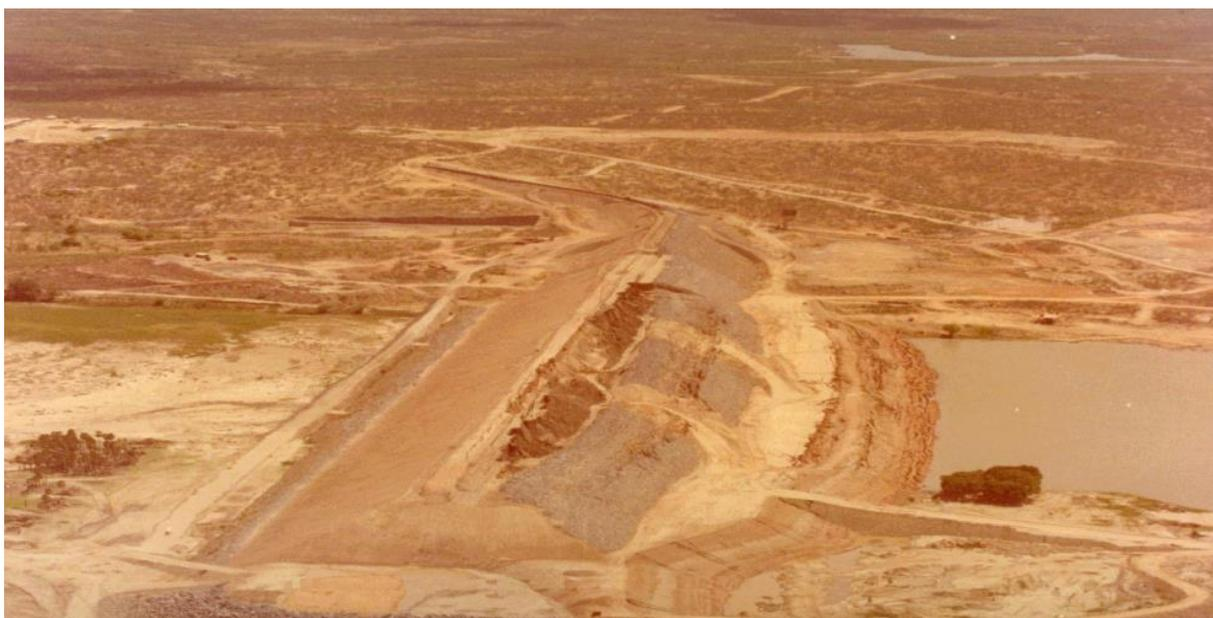
**Figura 3.6** – Vista aérea do talude rompido. (Rocha, 2003)
