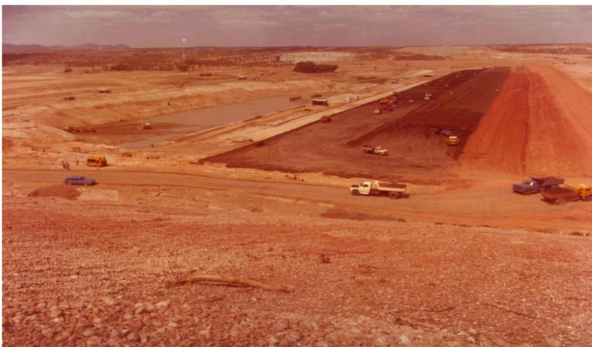
**Figura 3.3** – Construção da barragem central e início da escavação do *cut off*. (Rocha, 2003)
