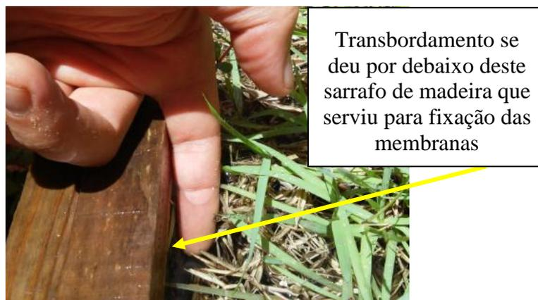
Figura 4.7 - Acúmulo de água na parte interna do MVGT.
