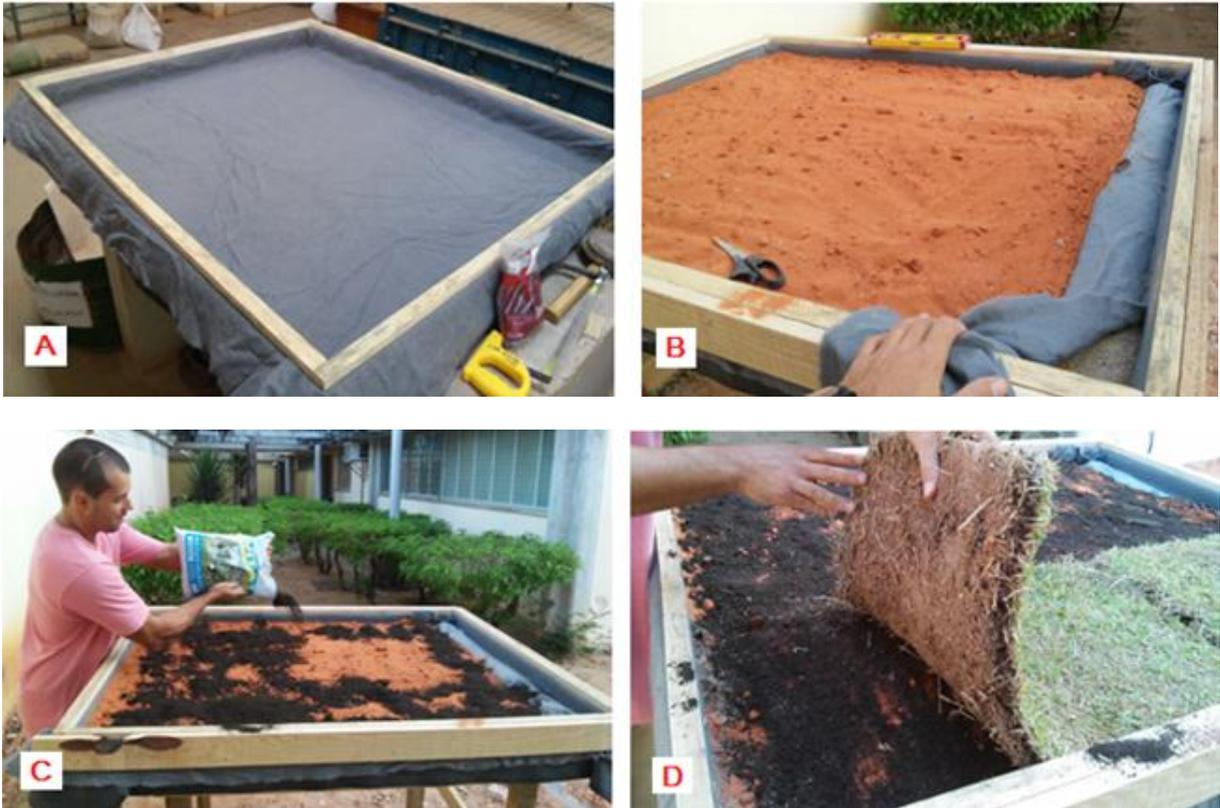
Figure 3.6 - Sequência construtiva do Módulo Vegetado Geotêxtil: A) fixação do geotêxtil sobre a geomembrana; B) detalhe para a barreira drenante; C) colocação do adubo orgânico; D) plantação da vegetação.
