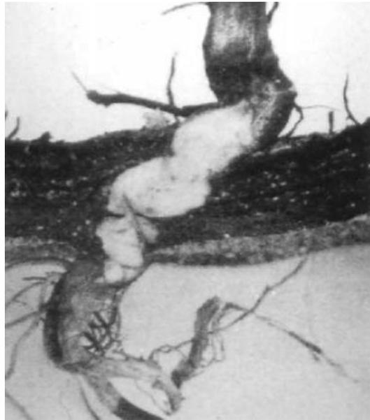
Figura 2.8 - Camada de impermeabilização sendo atravessada por uma raiz.
