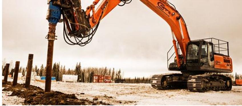
Figura 6: Trator adaptado com motor a trado para execução de estacas helicoidais (COPP'S Services INC, 2015).
