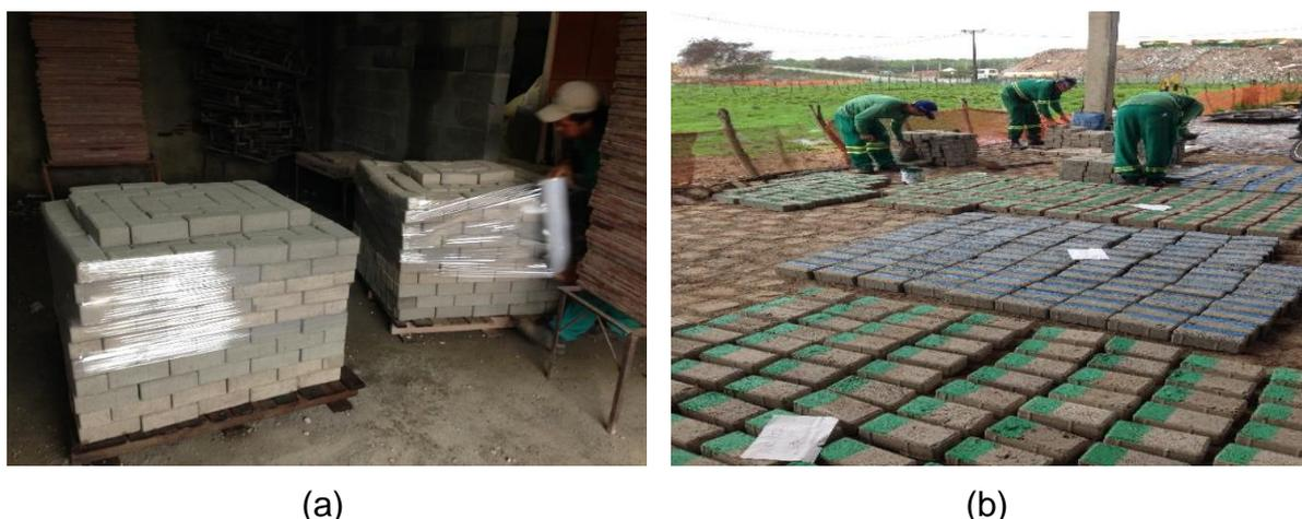
Figura 3.18 – (a) Paletização dos blocos confeccionados; (b) Pintura dos blocos para diferenciar as dosagens na construção do protótipo.
