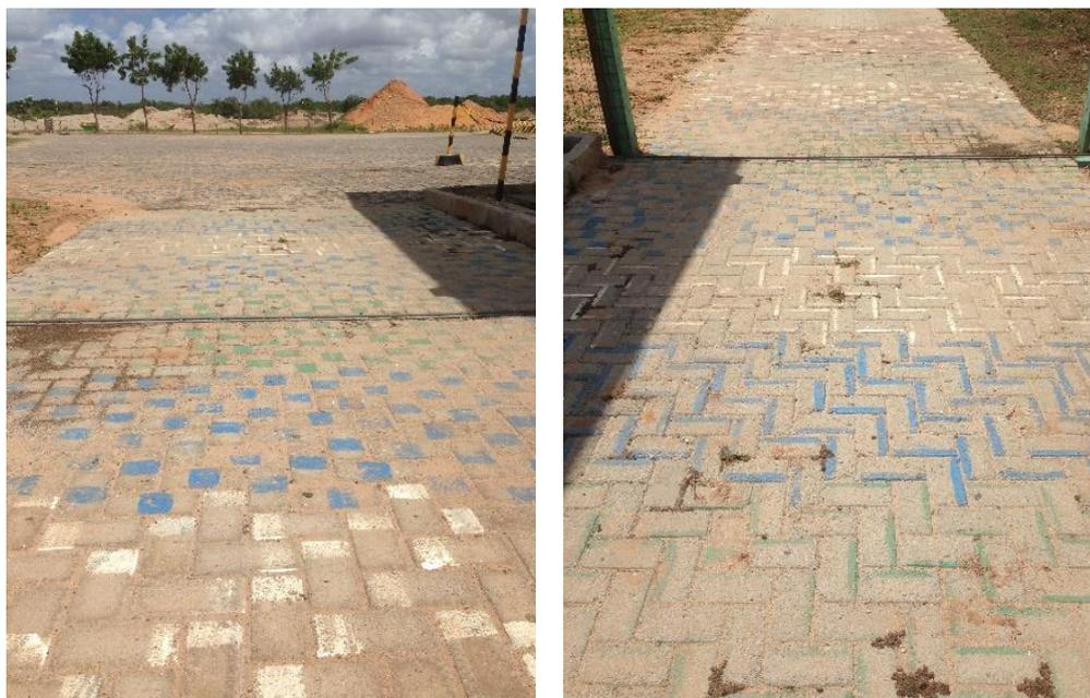
Figura 4.14 – Protótipo construído na Usina, após um ano de uso.
