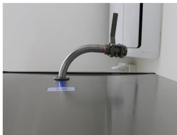
Figura 56: Tubulações em curva: (a) Curvatura da tubulação de entrada de CO<sub>2</sub> e ar; (b) Curvatura da tubulação de saída de ar - Fonte: Autor (2015).
