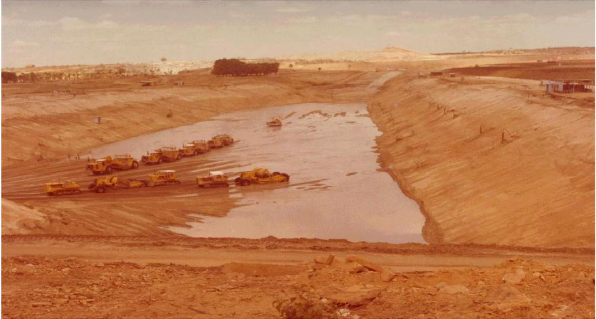
Figura 3.6 – Nível d'água aflorante na escavação do *cut-off* (Rocha, 2003)
