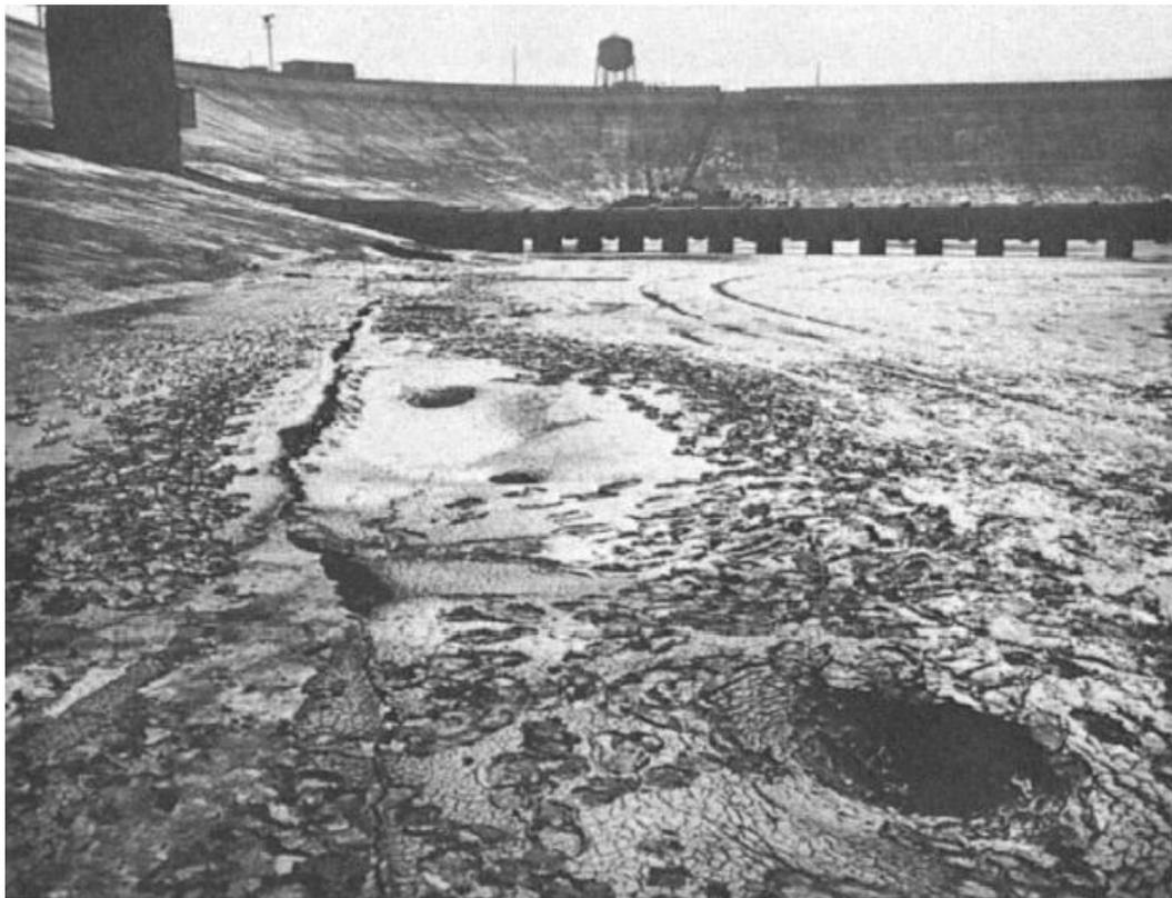
Figura 2.25 – Fotografia de dentro do reservatório após a ruptura (Jansen, 1987)
