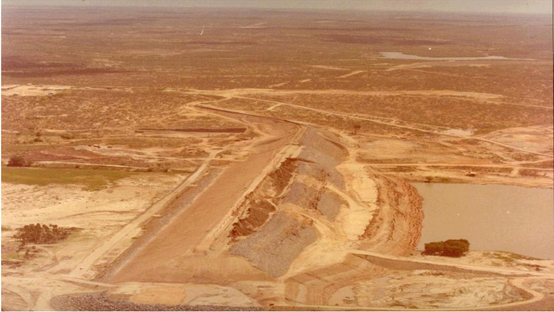
Figura 3.10 – Vista aérea do talude rompido (Rocha, 2003)
