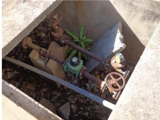
**Figura 06** – Ligações dos pontos de injeção direta na rede. **Fonte:** AUTOR (2016)
