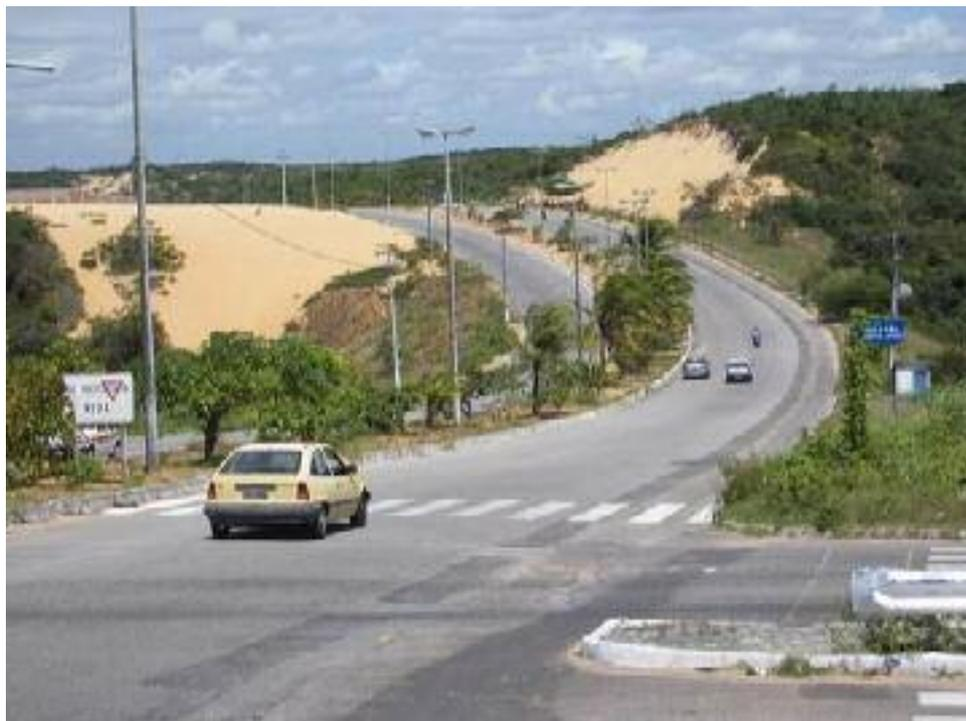
Foto 12 - Área dunar sem vegetação (à esquerda) e talude em processo erosivo (à direita)
