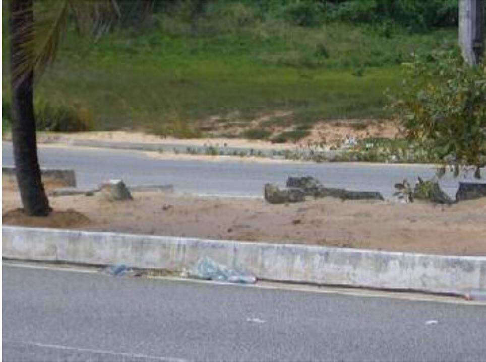
Foto 15 - Meio fio do canteiro central necessitando recomposição
