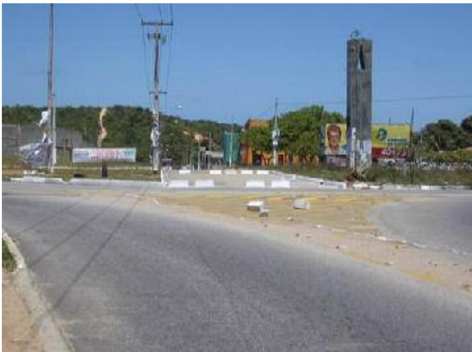
Foto 27 - Conservação deficiente da rótula. Detalhe para os blocos de concreto na pista
