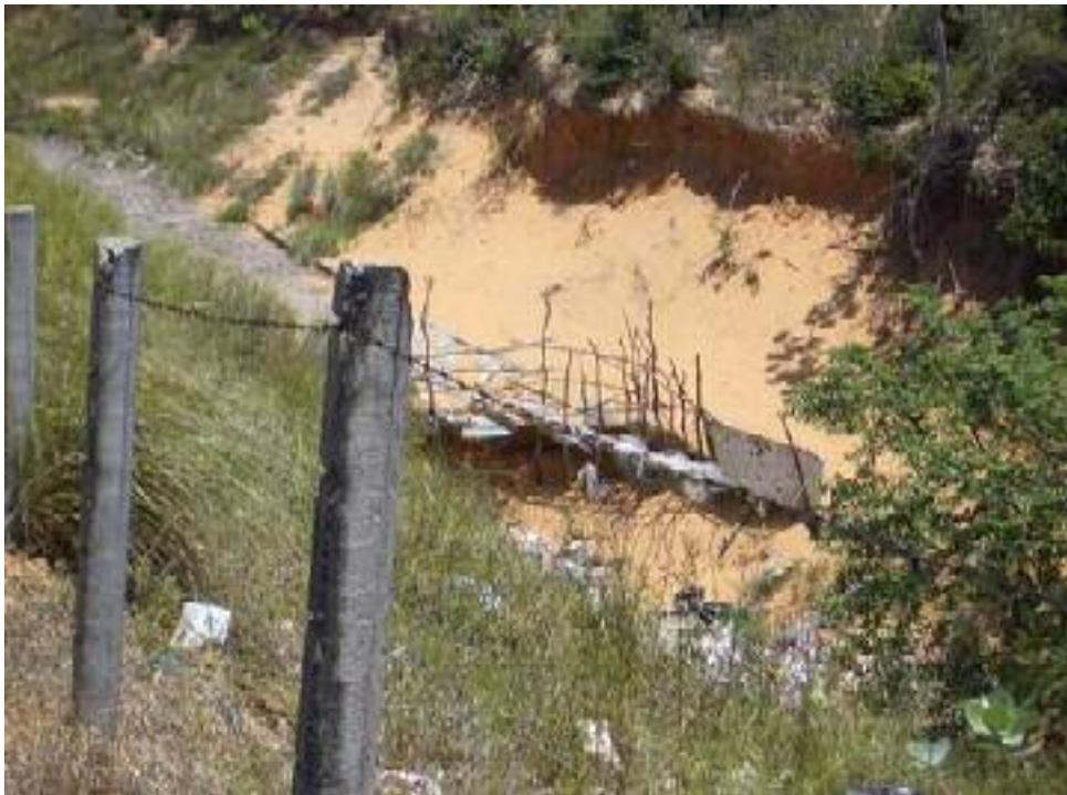
Foto 20 - Falta limpeza da calha. Talude em processo erosivo.
