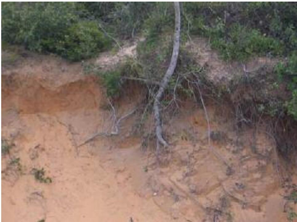
Foto 11 - Erosão em talude, com exposição de raízes - Deficiência no processo de estabilização do solo.
