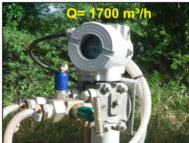
**Figura 3.24- Transmissor de vazão da água bruta/Jiqui**
