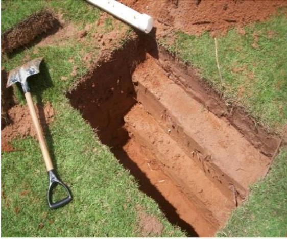
Figura 25: Escavação nas profundidades de 30,60 e 90 cm
