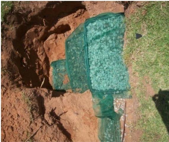
Figura 34: Instalação das bandejas em um dos conjuntos de coletores
