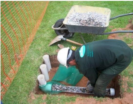
Figura 29: Instalação de um dos coletores de 30 cm
