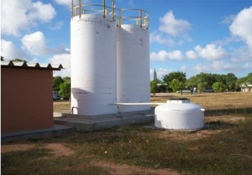
Figura 17: Configuração original da estação de tratamento de esgoto UO-RNCE da PETROBRAS em Natal, em agosto de 2008.
