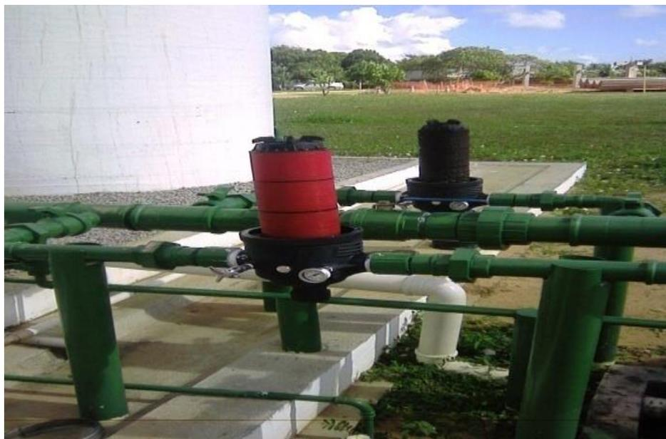
Figura 53: Comparação entre os filtros, antes e depois da limpeza
