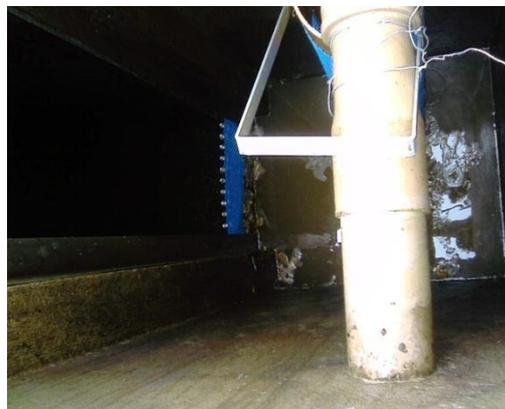
Figura 41: Instalação da tela no poço mais próximo a ETE da UO RNCE PETROBRAS (2010)
