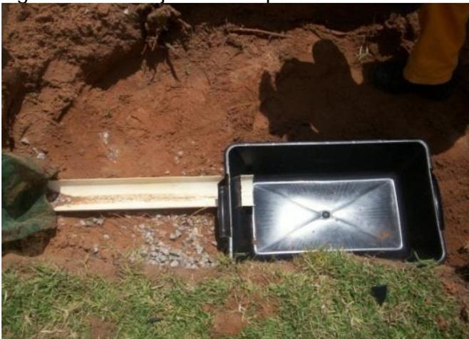
Figura 32: Acoplamento do tubo à bandeja
