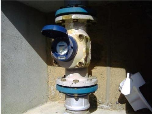
Figura 36: Hidrômetro Instalado na estação
