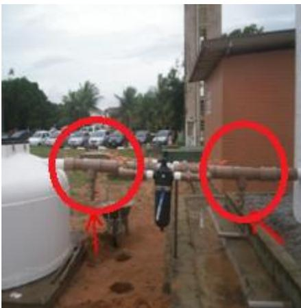
Figura 21: Ponto de coleta na saída do reator aeróbio ( $P_3$ ) e após o filtro ( $P_4$ )
