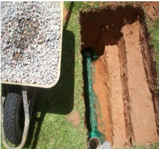
Figura 27: Colação da tela em um dos coletores de 90 cm
