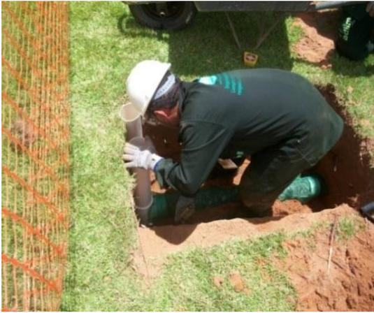
Figura 28: Instalação de um dos coletores de 60 cm
