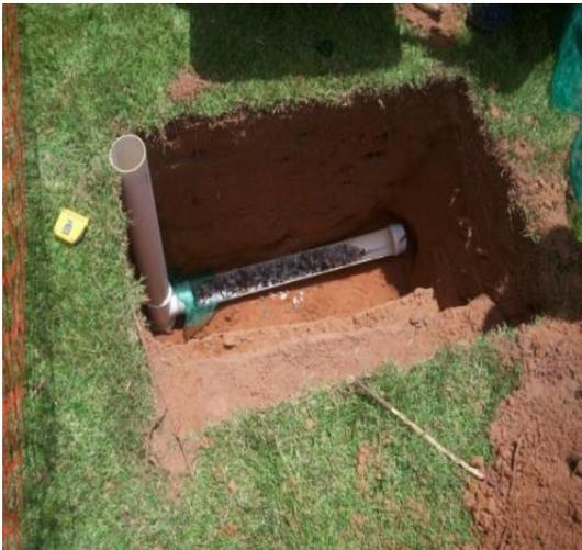
Figura 26: Preenchimento do tubo seccionado com brita
