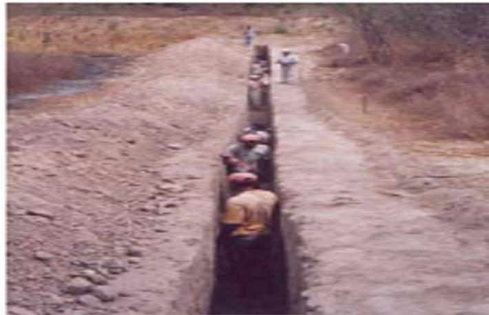
Figura 05 – Escavação Manual (Fonte: BARBOSA et al, 2006).
