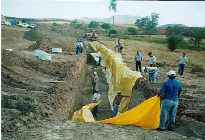
Figura 06 – Impermeabilização (Fonte: BARBOSA et al, 2006).
