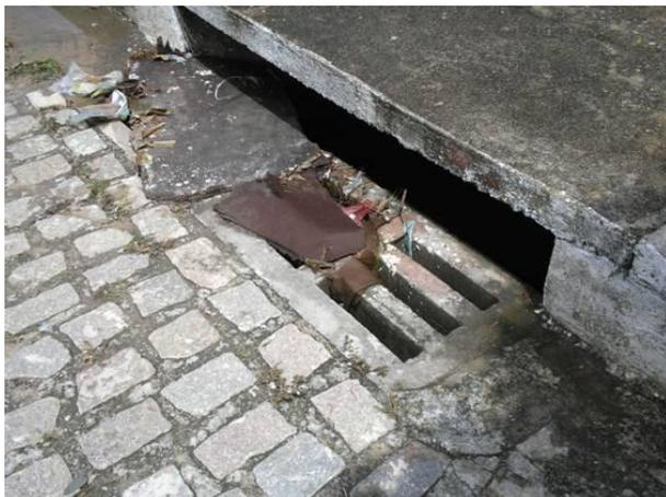
Figura 3.4 Boca de Lobo obstruída com resíduos carreados da superfície (Ano 2007).
