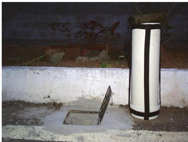
Figura 4.9 Coletor simples para bacia instalado
