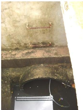
Figura 4.7 Instalação da sucção do amostrador na tubulação de descarga
