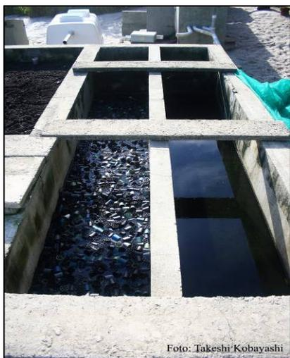
**Figura 19: Visão geral dos filtros anaeróbios**
