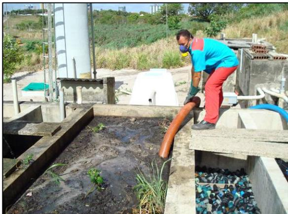
**Figura 22: Esgotamento tanque-séptico**
