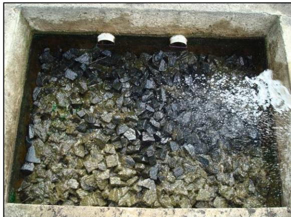
**Figura 23: Esgotamento filtro de pedra**
