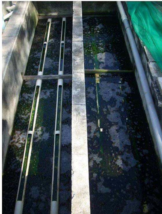
**Figura 3.30: Lodo depositado nas canaletas de coleta e distribuição**
