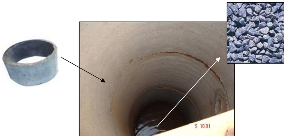
**Figura 10: Fossa feita de anéis de manilha e o fundo com pedra britada**
