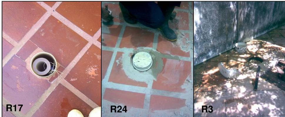
**Figura 21: Tampas de inspeção feitas com tubulação em PVC com 150 mm Ø**
