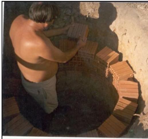
**Figura 9: Construção de uma fossa-sumidouro ou Fossa Absorvente com tijolos invertidos**
