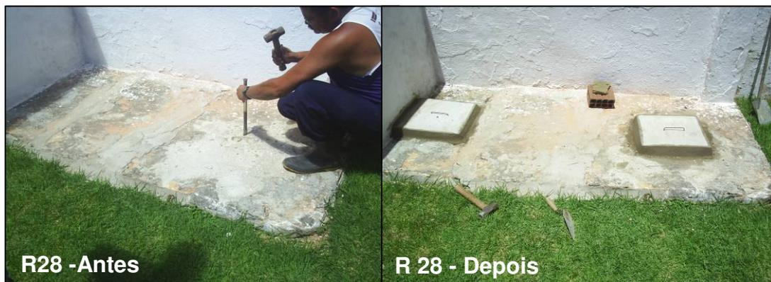
**Figura 26: Tanque séptico com duas câmaras em série antes e depois das tampas custeadas pelo projeto**
