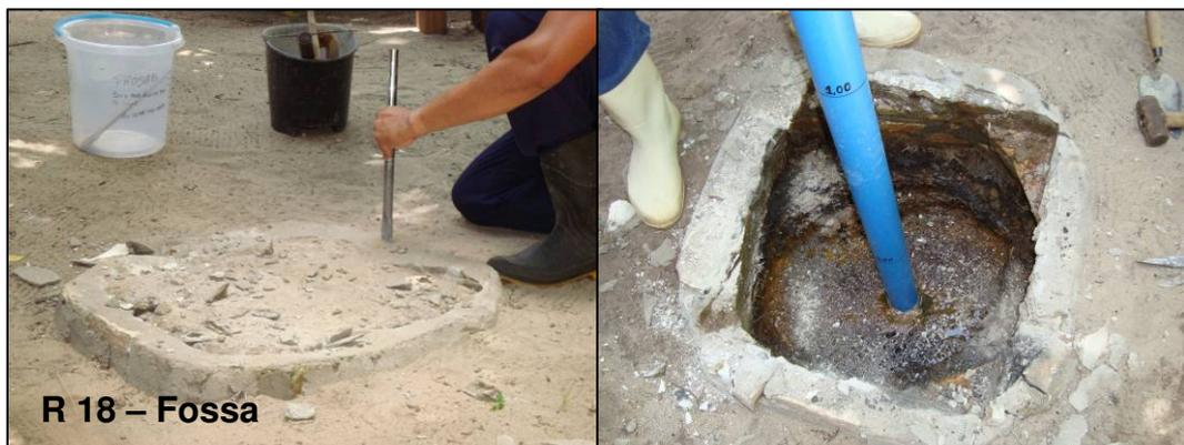
**Figura 24: Sistema (fossa) com toda sua tampa retirada**
