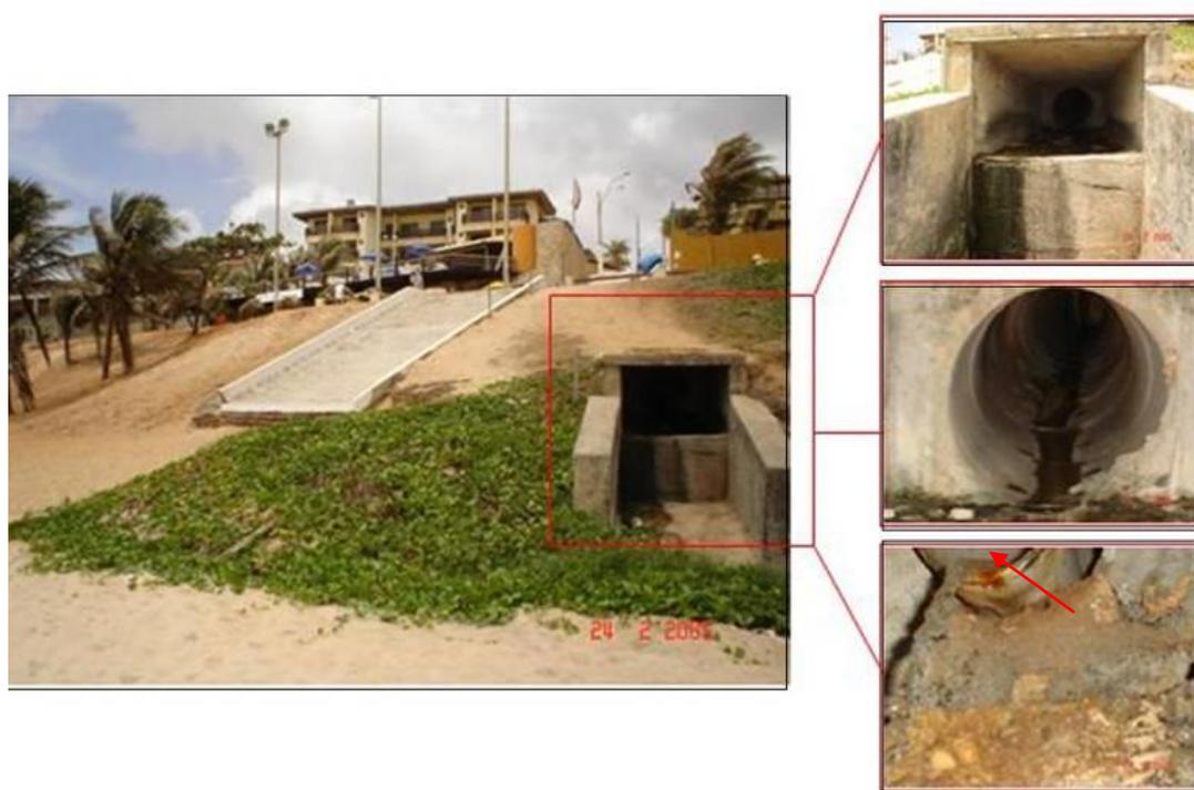
**FIGURA 4.7: Detalhe para o flagrante de uma ligação clandestina de águas servidas à rede coletora pluvial localizada em frente ao ponto NA-04 (Ponta Negra/ Final do Calçadão).**
