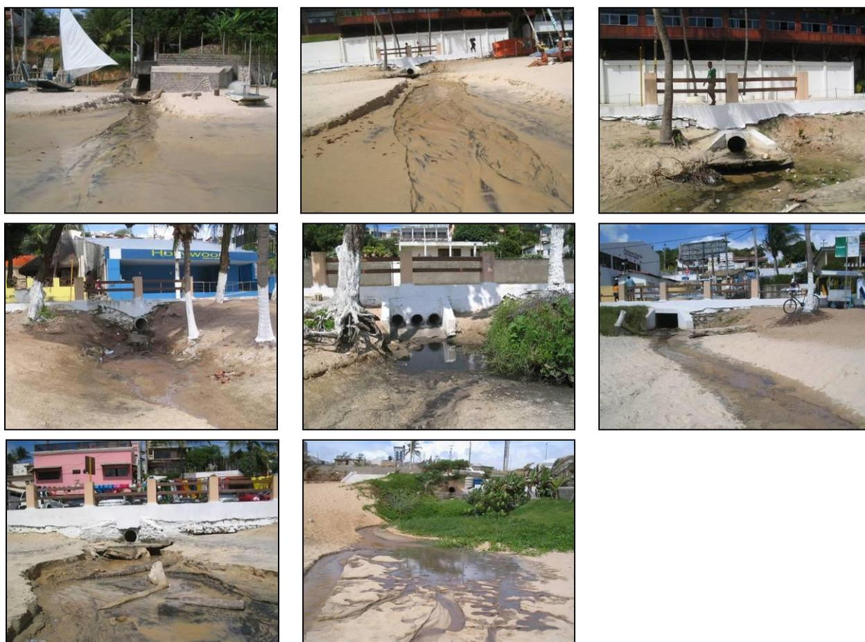
**Figura 4.6: Extravasamento de esgoto nas galerias pluviais ao longo da praia de Ponta Negra (Fotos registradas no dia 14/06/2005).**
