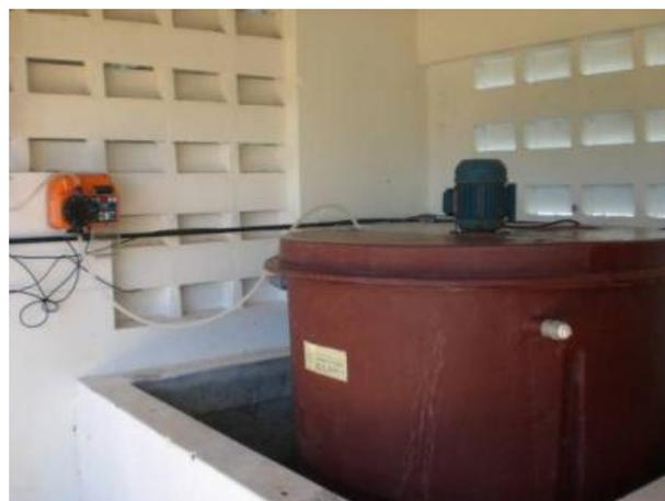
**Figura 20. Tanque de dosagem bomba dosadora.**
