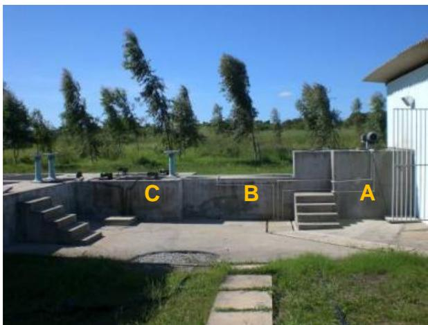
**Figura 15. Neutralização (A), calha Parshall (B) e floculadores (C).**
