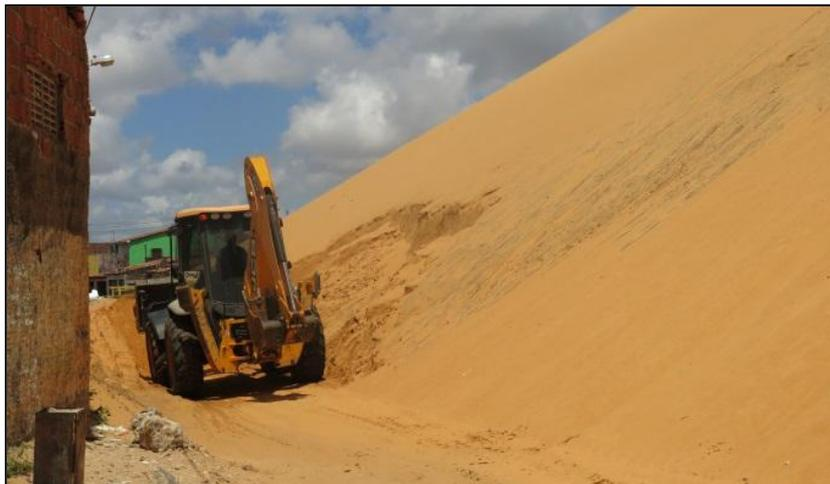
Figura 32. Deslizamento dos sedimentos do remanescente de duna próximo ao braço longitudinal NW-SE da ZPA 01 e medida de alargamento da rua, onde são retirados os excessos de areia.
