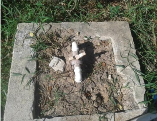
**Figura 7 - Registro para regular a vazão do efluente da Lagoa maturação**
