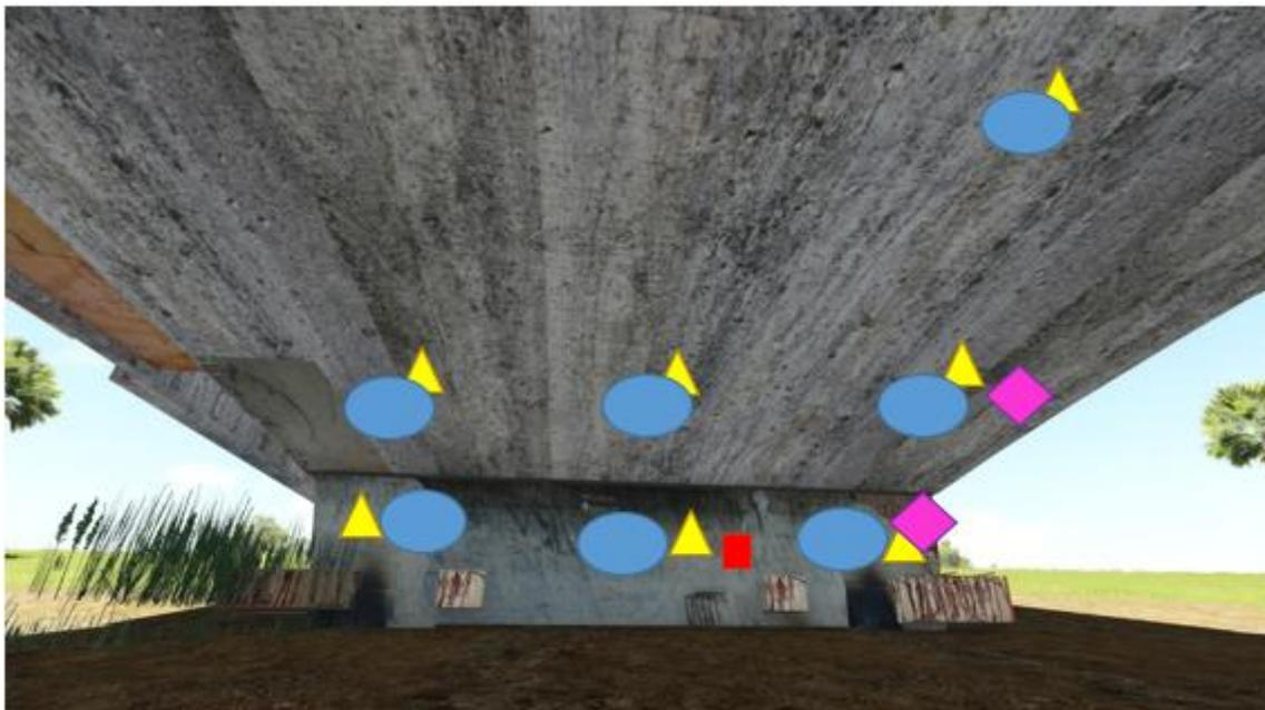
Figura 30: Representação gráfica da viga de contraventamento e da laje com as marcações dos ensaios não destrutivos – Fonte: Autor (2015).
