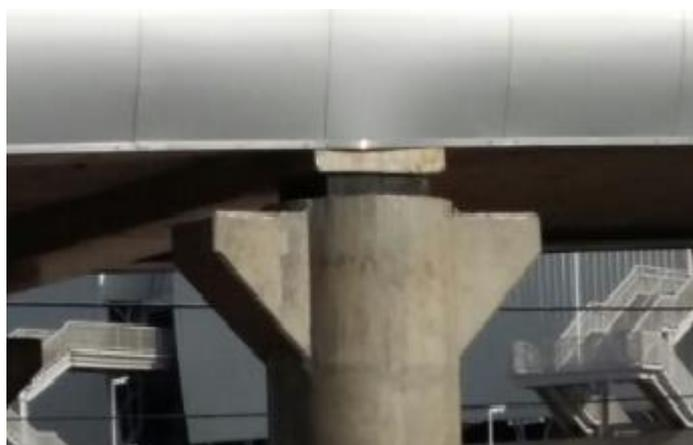
Figura 4: Ligação da superestrutura e mesoestrutura por aparelho de apoio de Neoprene - Fonte: Autor (2015).
