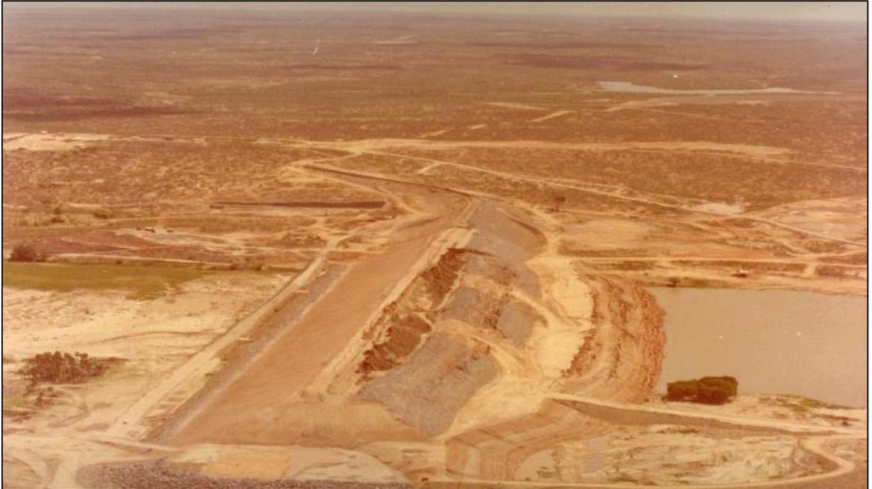
Figura 3.9: Foto aérea da vista da ruptura do talude de montante da barragem central
