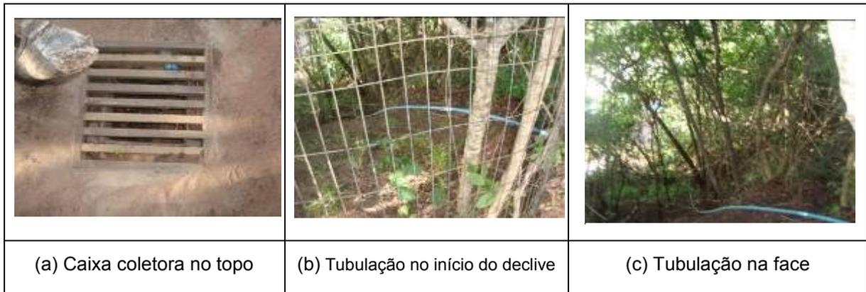
Figura 3.9 - Detalhes da caixa coletora de águas pluviais no topo da falésia da Ponta do Pirambu (Severo, 2011)
