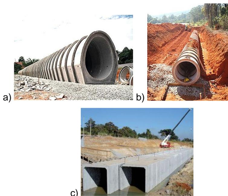
Figura 2.1 – Formas de dutos encontrados em obras civis: a) forma oval, b) forma circular e c) forma retangular (Aca tubos, 2013).
