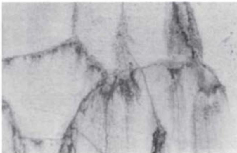
Figura 2-10 – Fissuração por retração do concreto. Fonte: (SOUZA & RIPPER, 2009)
