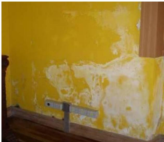
Figura 2.9: Presença de eflorescência através de manchas esbranquiçadas.
