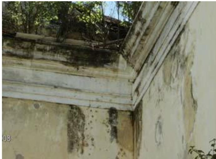
Figura 2.12: Presença de fungos no topo da parede.
