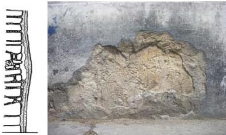
Figura 2.10: Exemplo de expulsão de argamassa com conseqüente desprendimento de revestimento.
