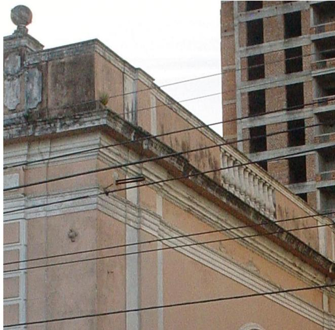
Figura 2.13: Exemplo de sujidade em fachada, principalmente nos detalhes arquitetônicos.
