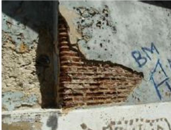
Figura 2.11: Exemplo de expulsão de argamassa em estágio avançado até a exposição da alvenaria, mostrando tijolos cerâmicos e argamassa de assentamento.
