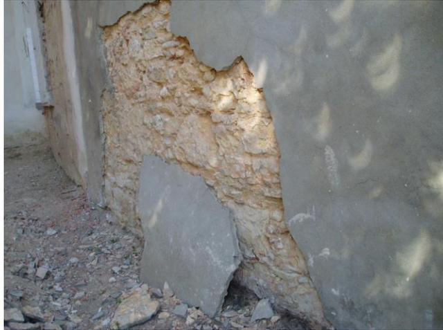
Figura 2.14: Revestimento inadequado de cimento: destacamento e degradação da base.
