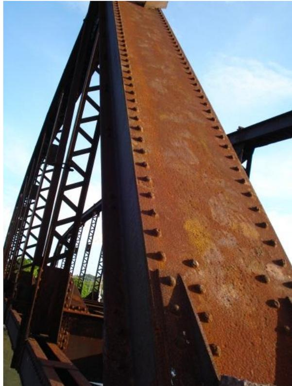
Figura 4.1.20 – As maiores vigas em I da estrutura são as de 36 polegadas (88,2 cm) indicadas na figura abaixo.
