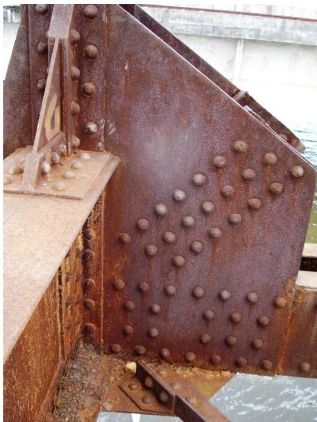
Figura 4.1.18 – Corte G-H mostrando a seção superior da treliça espacial constituída de uma chapa lisa superior, duas chapas em C nas laterais e treliçado no bordo inferior. Todas as uniões eram em rebites batidos.
