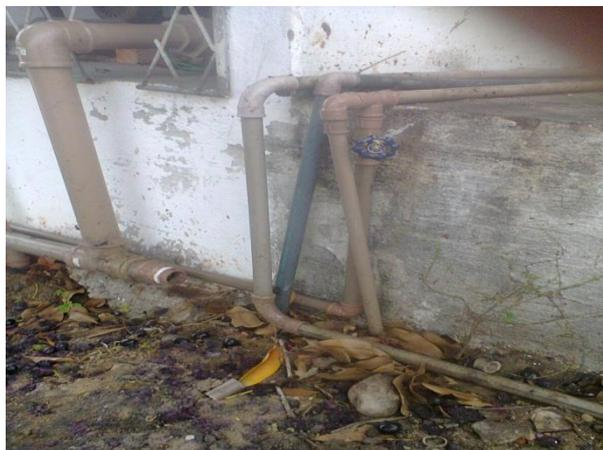
Figura 6: Tubulação de ar para a bomba/soprador. Fonte: Autor (2013)
