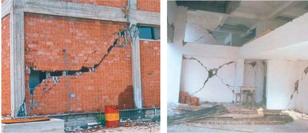
Figura 6.5 - Patologia reais de fissuras com diagonais simples e em cruz (LESTUZZI:2008a)
