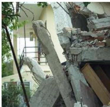
Figura 3.37 - Colapso devido a rigidez inadequada do nós (PLUMIER:2007)
