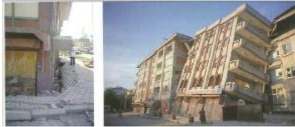
Figura 6.12 - Patologia devido à liquefação (LESTUZZI:2008)
