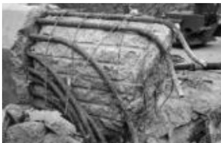
Figura 3.36 - Falha ocorridas na ligação do pilar com a fundação (YASHINSKY:1999)
