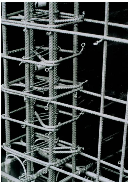
Figura 6.24 - Detalhamento sugestivo de estribos para vigas e pilares segundo o EUROCODE:2008
