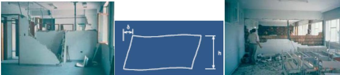
Figura 3.25 - Danos típicos causados em elementos não estruturais devido a deformações na estrutura durante solicitações sísmicas (BACHMANN:2003)
