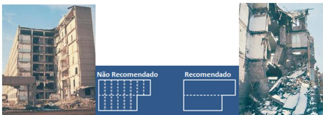
Figura 3.29 - Patologias geradas devido à falha no comportamento do diafragma (BACHMANN:2003)
