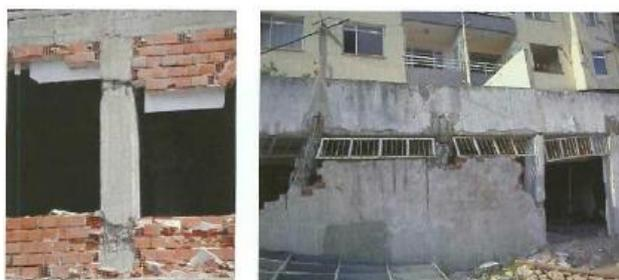
Figura 6.9 - Danos por esforço cortante em um pilar devido ao mecanismo de coluna curta (LESTUZZI:2008)
