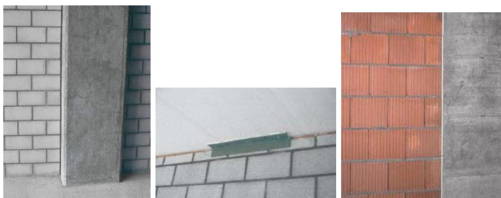
Figura 3.24 - Representação das juntas verticais separando os elementos estruturais dos não-estruturais (HERNÁNDEZ:2009)
