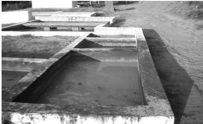
Figura 2.3 – Leito de secagem do lodo da lagoa anaeróbia do km-6 da BR 226.
