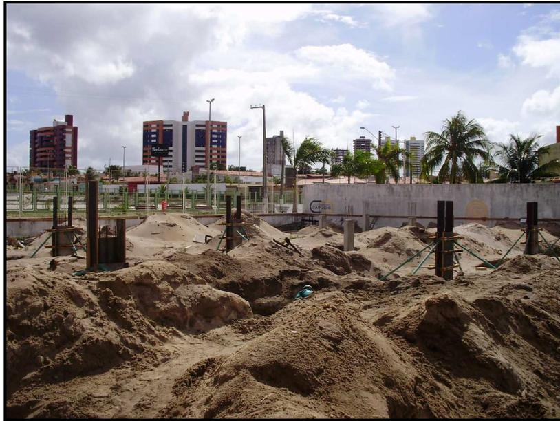
Figura 3.4 Vista geral da obra durante a execução das fundações diretas.
